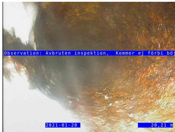
1_0006.jpeg, 00:10:18, 20.21m Avbruten inspektion, Kommer ej förbi böj / Kommer ej förbi böj
